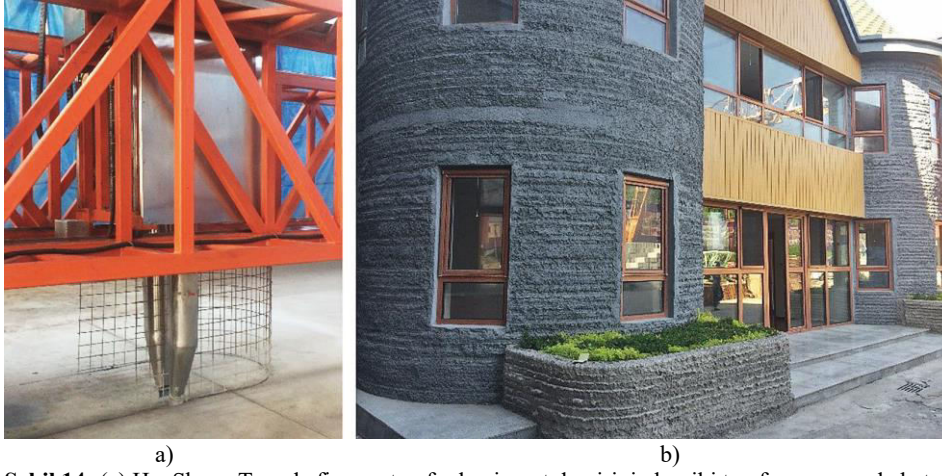
Şekil 14: (a) HuaShang Tengda firması tarafından inşaat demirinin her iki tarafına aynı anda beton yerleştiren gelişmiş nozul, (b) Çin’de HuaShang Tengda firması tarafından 3B yazıcı teknolojisini kullanarak yapılan ev
