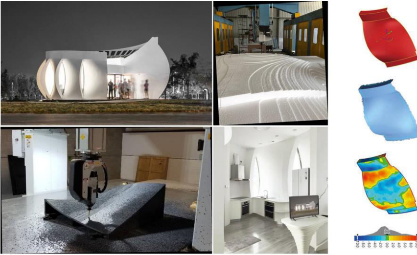
Şekil 16: Lotus evin 3B yazıcı teknolojisi kullanılarak yapılması
