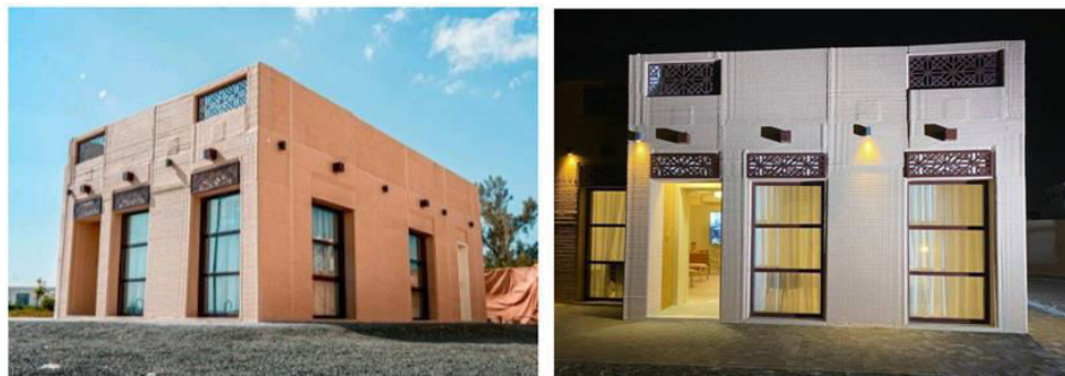
Şekil 13: Birleşik Arap Emirliklerinde 3B yazıcı teknoloji kullanılarak yapılan ev Kaynak: İbrahim vd., 2022
