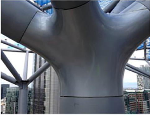
Şekil 8: Bevis Marks binasında 3B yazıcı teknolojiyle üretilen polimer kaplama Kaynak: Camacho vd., 2018
