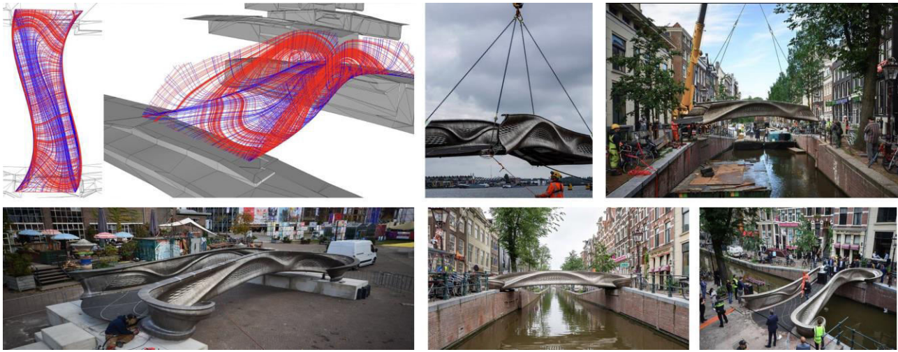
Şekil 6: Joris Laarman Lab ve Arup tarafından tasarlanan 3B yazıcı teknolojilerinden yararlanılarak yapılan çelik köprü Kaynak: URL 1
